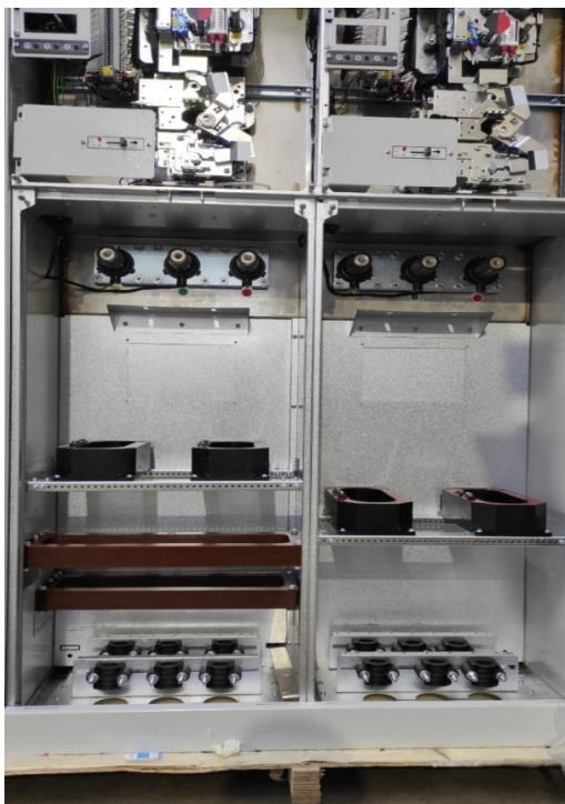
Рис. 1.4 Кабельный отсек
