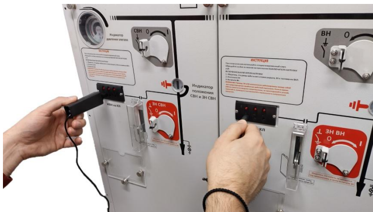
Рис. 5.6 Проведение фазировки
