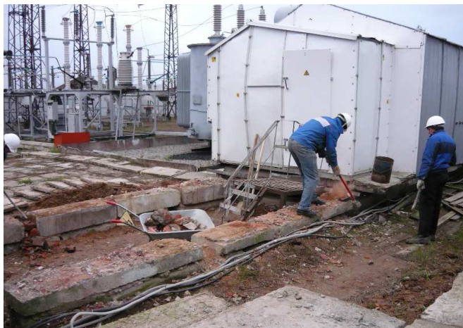
Демонтаж старого фундамента
