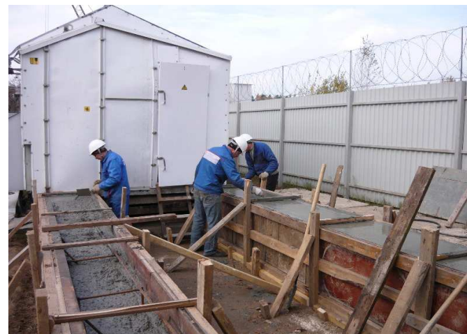
Сооружение нового фундамента
