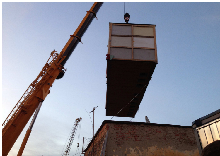
Установка БМ ЗРУ-1
