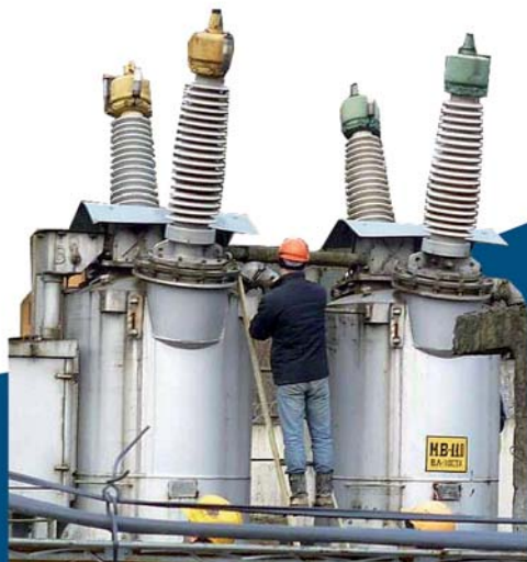
Выключатель 110 кВ масляный
